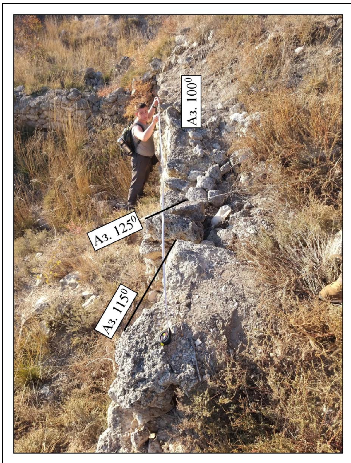
Рис. 3. Развороты пакетов блоков по часовой стрелке вокруг вертикальной оси в зоне разрыва. Фотография 2021 г. Вид на запад. Показаны азимуты простирания повернутых пакетов и недеформированной части стены.
